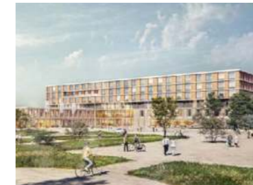
Neubau Klinikum Memmingen
